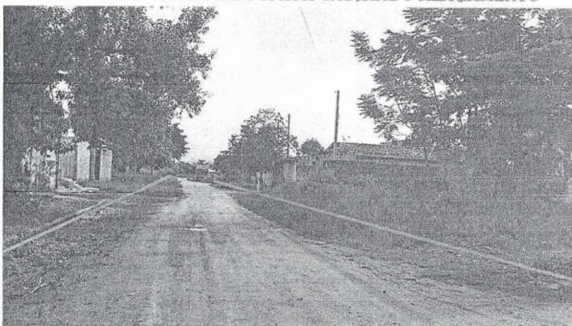
RUA 25 - MATO INVADINDO A RUA CAUSANDO ALAGAMENTO
